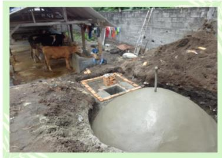
Gambar 2. 12 Pembangunan Biogas Ternak
